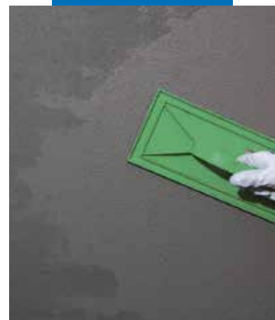
Zacieranie powierzchni Mapegrout 430
