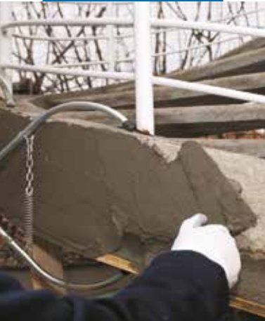
Nanoszenie Mapegrout 430 pacą
