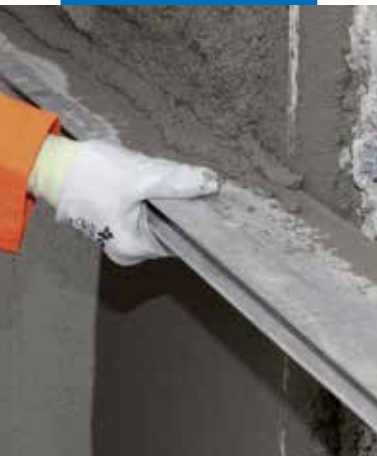
Wyrównywanie powierzchni łatą
