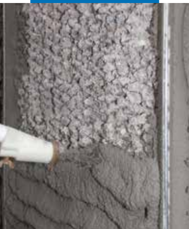
Nanoszenie Mapegrout 430 maszynowo
